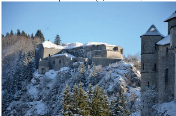
Le fort du Larmont Inférieur, et la tour du Diable. (©-R.BOIS 2014)
