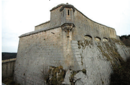
Vue du sud-est, face sud, guérite et galerie de fusillade.
