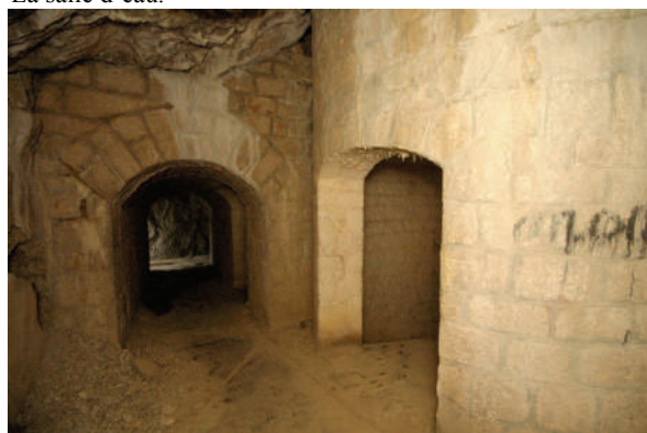
Vers cour, abri sous roc et escalier vers caserne haute.
