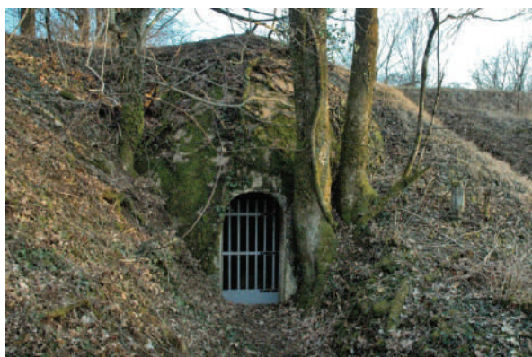
Puits d'accès à vis suspendu Est.
