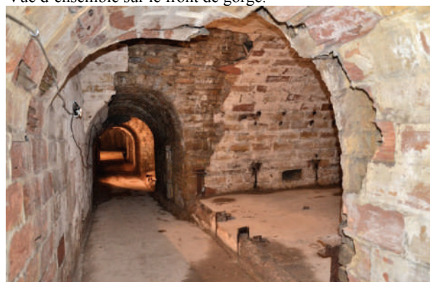
La galerie centrale et les casemates logements. (©-Photos R.BOIS)
