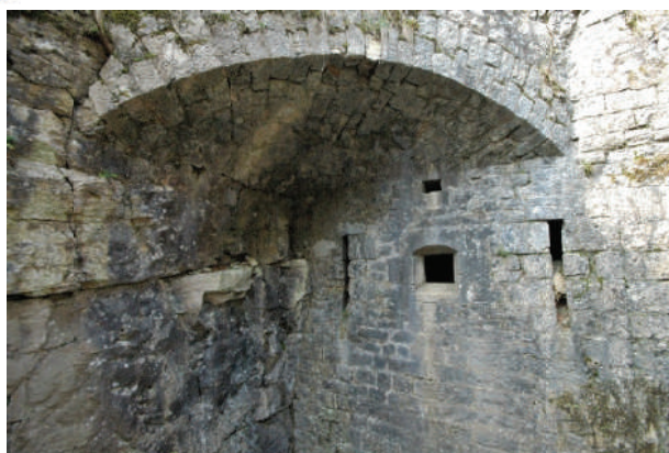
Coffre de contrescarpe du Réduit (Sud-ouest)
