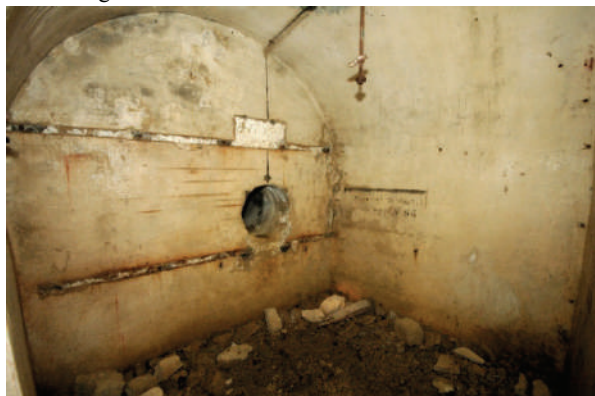
Poste optique sud.
