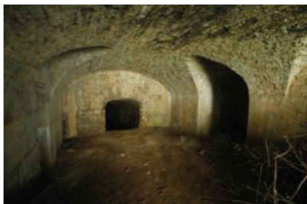
Rez-de-chaussée de la Tour Réduit de Sureté.
