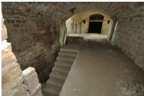
Traverse centrale, le puits de manutention.
