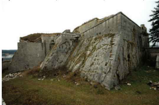
Vue du nord-est sur les redans et la façade nord.
