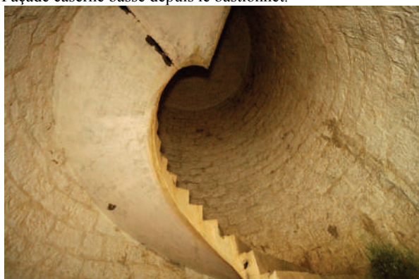
Escalier en vis suspendu menant vers les dessus.
