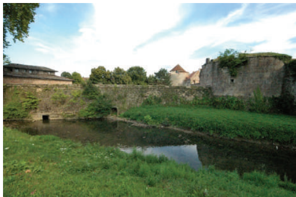
Courtine ouest et Tour du Moulin.
