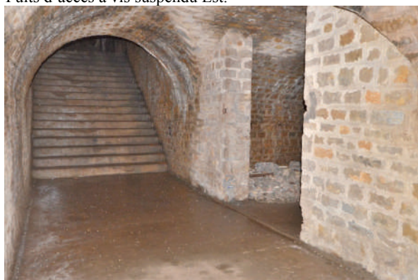
L'escalier d'entrée et la casemate caverne Est.
