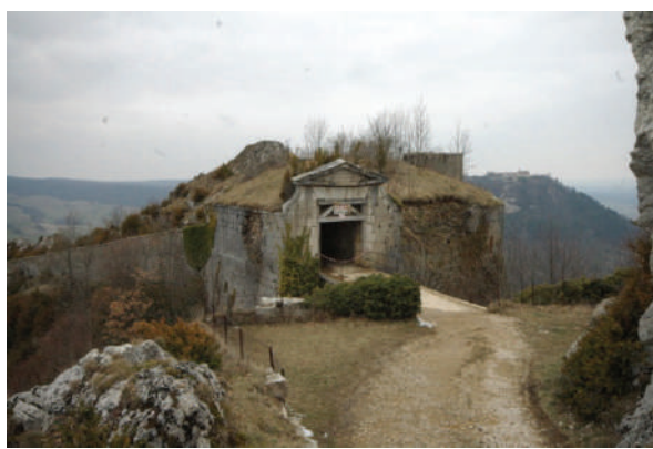
Redoute de Grelimbach. Au fond à droite St-André.
