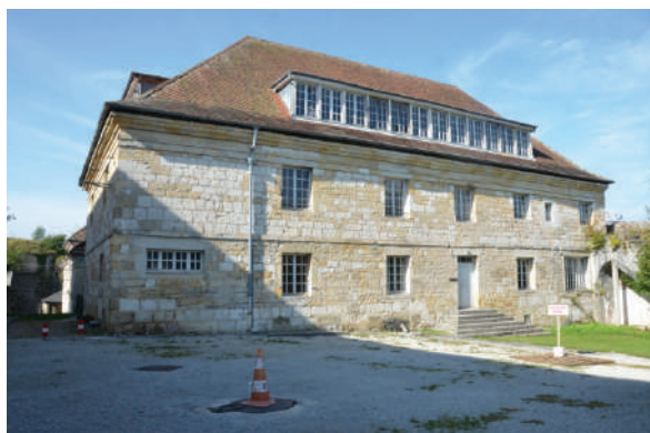
Logement du Gouverneur.
