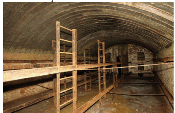
Abri sous roc. (Plans et photos ©-Roland BOIS 2014)
