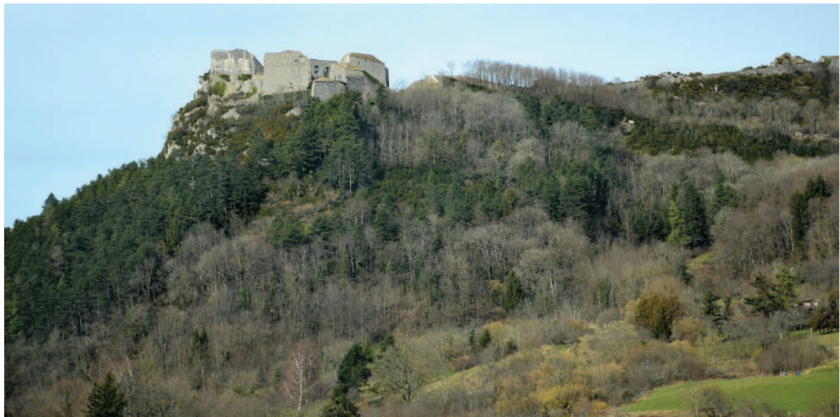
Depuis le sud. Le Réduit et le Cavalier de Belin, la Communication, le Poste Optique et la Redoute de Grelimbach. (©R.BOIS 2014)
