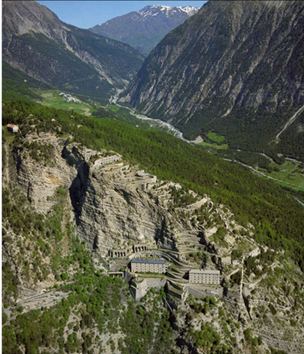
Fort de Tournoux (1846-1865), Ubaye, Alpes-de-Haute-Provence
