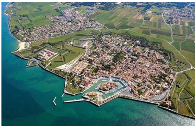
Citadelle & Enceinte urbaine de Saint-Martin-de-Ré
