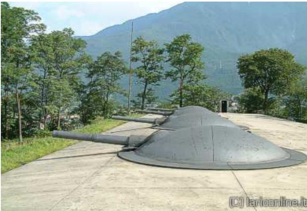
Les canons étaient équipés d'un frein, d'un dispositif anti recul et d'un système à air comprimé pour l'évacuation des gaz de tir. Chaque canon pèse 3,8 tonne et pouvait tirer divers types d'obus, des obus de 52 kg sur une portée de 11,6 km, des obus de 42kg sur 12,1 km et des obus de 37 kg sur 14,2 km.
