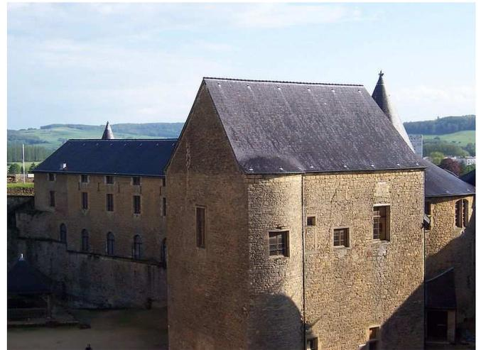
Vers 1550 sont créées les terrasses à canons par remplissage en terre, entre les remparts et une nouvelle muraille prise sur la basse cour, augmentant l'épaisseur des courtines de 4,50 m à 26 m, 18 petits logis pour la troupe ont été créés dans ce remplissage.
